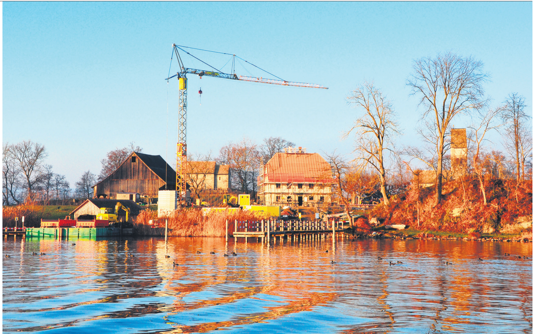
Ein Kran und das eingerüstete «Haus zu den zwei Raben» prägen derzeit das Bild auf der Ufnau.
