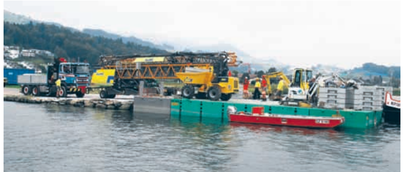
Ein Lastwagen schiebt den Kran auf den Ponton. Entladen wird er später mithilfe der Dumper, der die Überfahrt ebenfalls mitmacht.
