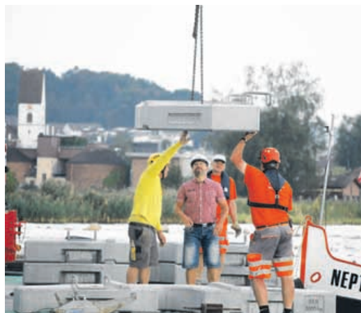
Zwei Tonnen schwere Betonklötze, normalerweise als Gegenballast für den Kran verwendet, dienen dazu, den Ponton auszugleichen.
