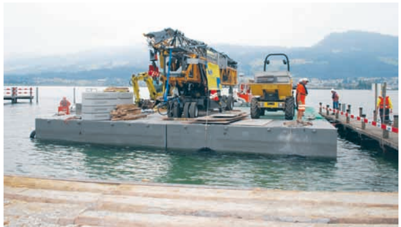
Exakt berechnet: Der Ponton ist genau gleich hoch wie die Anlagestelle.
