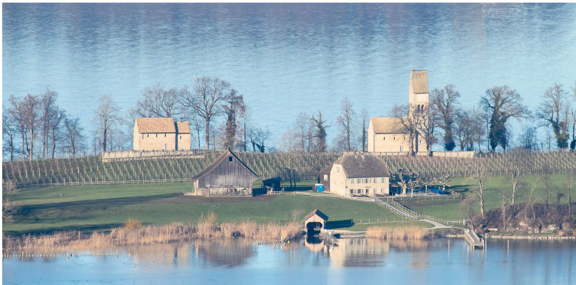
Das Kloster Einsiedeln hat den Umbau des Hauses zu den zwei Raben beschlossen. Ab Sommer wird der südliche Teil der Ufenau zur grossräumigen Baustelle.
