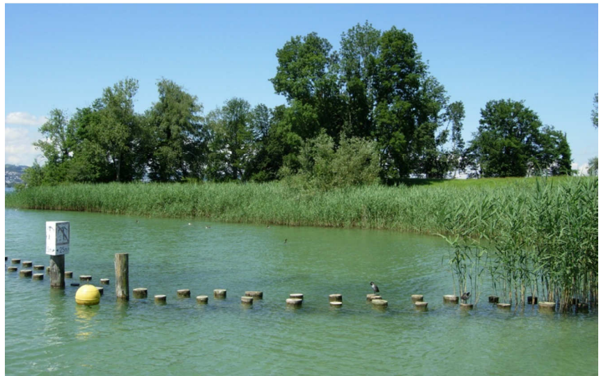
Abb. 3: Durchgehender dichter Röhrichtbestand hinter neuer Lahnung am Südwestufer (07.07.2012).
