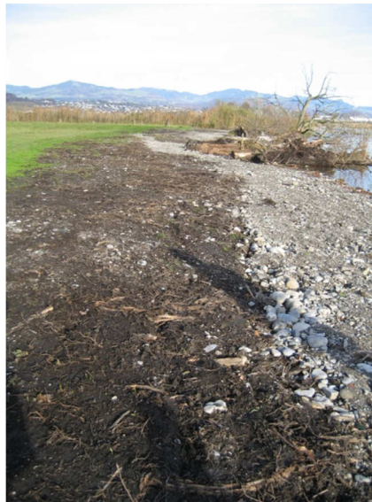
Abb. 5: Südostufer kurz nach Fertigstellung (20.11.06)
