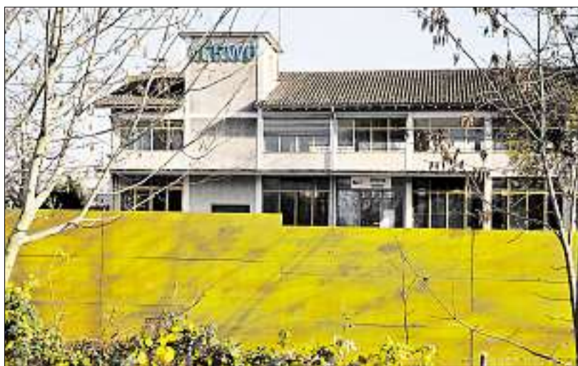
Das Verwo-Gebäude kam wegen Altlasten in die nationalen Schlagzeilen. (mme)
