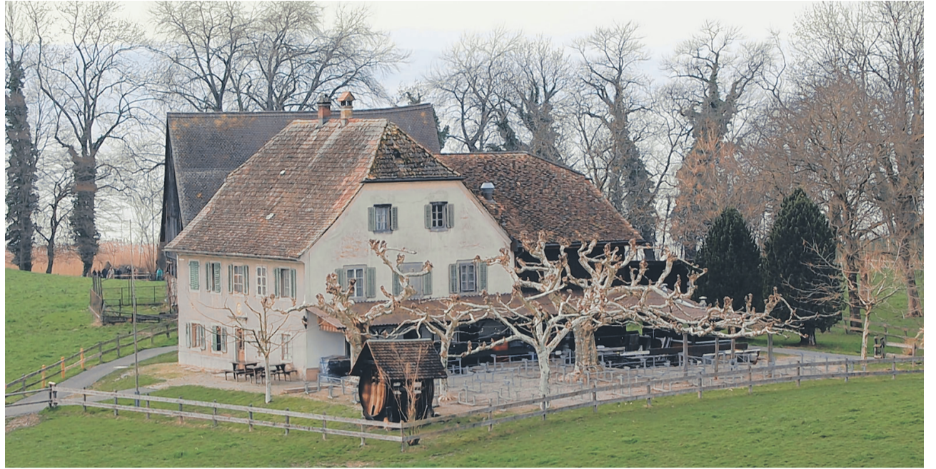
Das «Haus zu den zwei Raben» auf der Insel Ufnau muss sich noch eine ganze Weile gedulden, bis es auf Vordermann gebracht wird.
